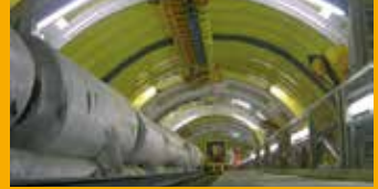
TUNNELBAU UND BAUWERKSABDICHTUNG
