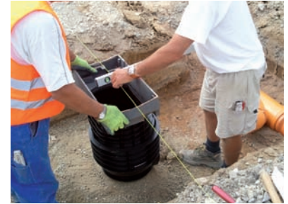
Optimale Ausrichtung des Ablaufes inkl. Aufsatz durch die Drehbarkeit, Teleskopierbarkeit und Anpassung an die jeweilige Quer- bzw. Längsneigung
