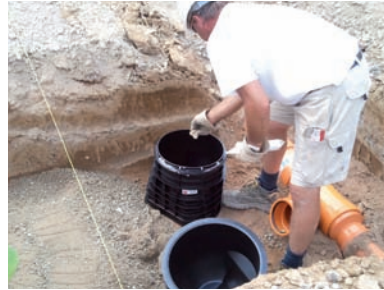
Vorbereitung der Oberteile durch Auftragen des Gleitmittels vor dem Ineinandersetzen.
