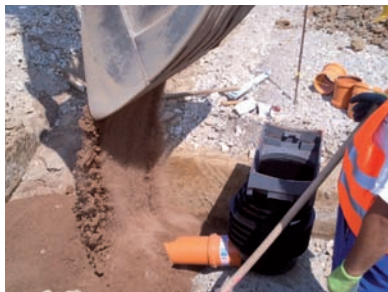
Verfüllen nach ON EN 1610 mit entspr. Verfüllmaterial.
