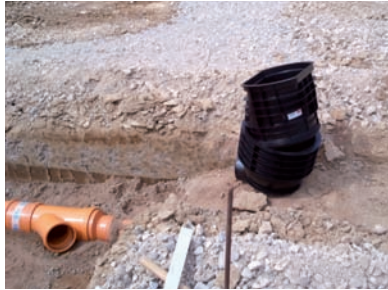
Leichtes Handling auf der Baustelle.
