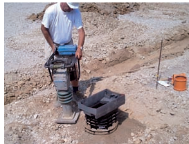
Verdichten mit leichtem Verdichtungsgerät bis zur Markierung „Unterkannte Beton“ auf dem obersten Kunststoffelement.
