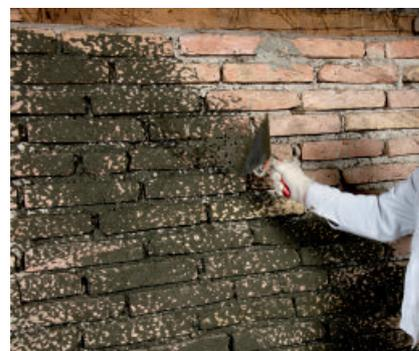
Zur Verbesserung der Anhaftung des nachfolgenden PCI Sanimentputzes erfolgt ein Spritzbewurf mit PCI Saniment HA.
