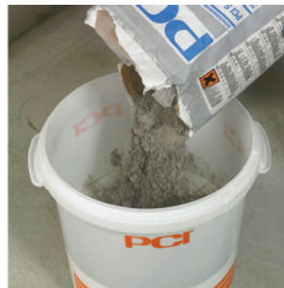
PCI Seccoral 2K Rapid Pulver dazugeben.
