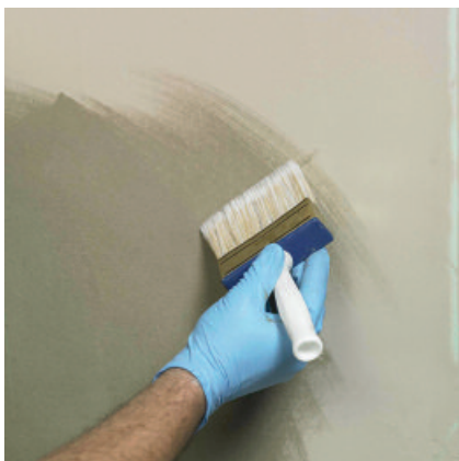
Untergrund mattfeucht vorbereiten.
