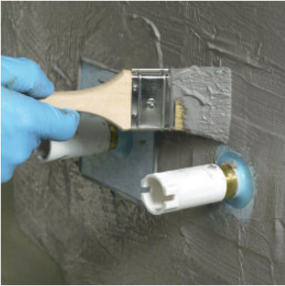
Die Dichtmanschetten PCI Pecitape 10 x 10 ordnungsgemäß einbetten.
