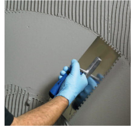
2. und evtl. 3. Auftrag im Spachtelverfahren mit einer geeigneten Glättkelle bis zur geforderten Gesamtschichtstärke aufbringen.
