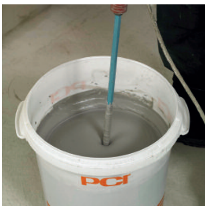
PCI Seccoral 2K Rapid für das Spachtelverfahren (1 a) zu einer homogenen Masse anmischen.
