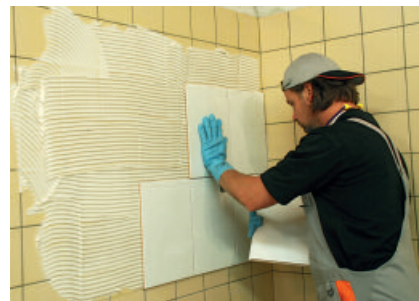
Verlegen von Wandfliesen mit PCI Bicolit® Extra auf alten keramischen Belägen.
