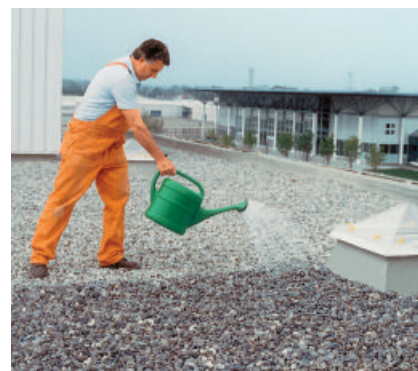
PCI Stabiflex verfestigt Kiesschüttungen auf Flachdächern und verhindert Kieswanderungen.
