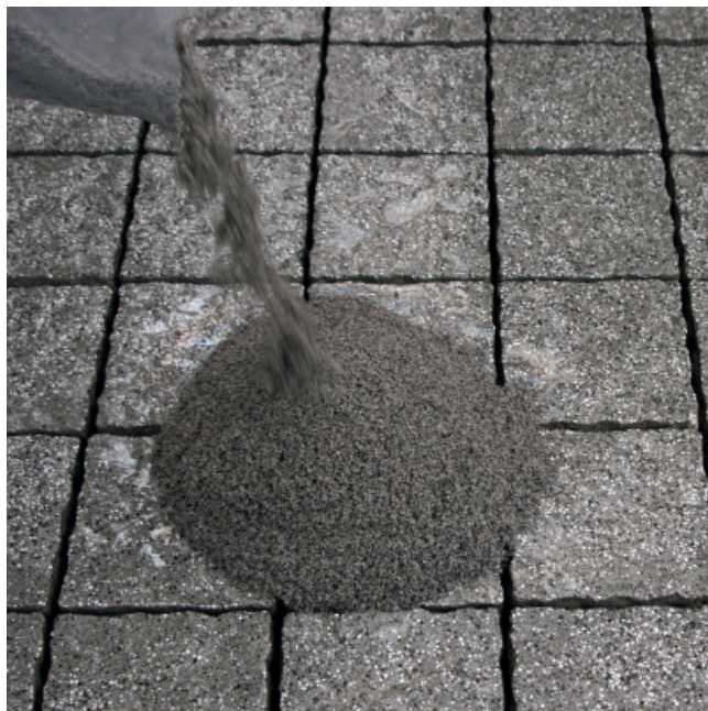
Vakuumbutel aufschneiden und frisches Material auf die nasse Belags- oberfläche schütten.
