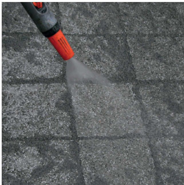
Bei Fugen von 3 - 8 mm das Einbringen in die Fugen mit dem Wasser- strahl unterstützen. Bei besonders schmalen Fugen den Wasserstrahl ent- lang den Fugen führen. Nachgesackte Fugen sofort mit frischem Material auffüllen.
