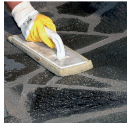
Innerhalb 1 Stunde Plattenbelag mit dem Schwammbrett nachwaschen.
