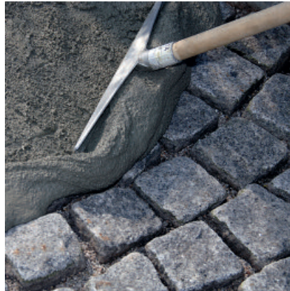
Beim Schlämmverfahren lässt sich PCI Pavifix CEM mit einem Gummischieber leicht in die Fugen einbringen.
