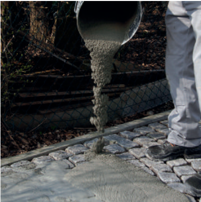
Aufbringen von PCI Pavifix CEM auf die zu verfugende Fläche.
