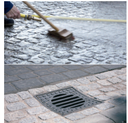
Beim Schlämmverfahren lässt sich PCI Pavifix CEM leicht mit einem Gummischieber in die Fugen einbringen.
