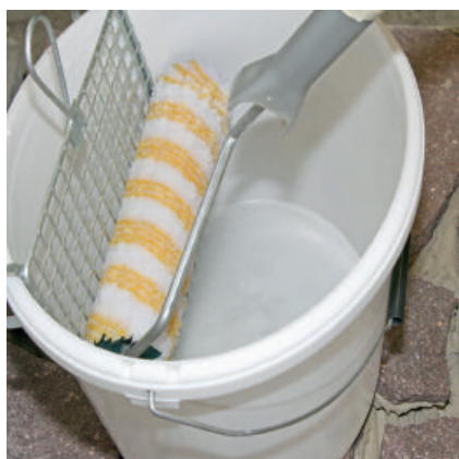
Vor dem Auftrag überschüssiges Material an einem Abstreifgitter entfernen...
