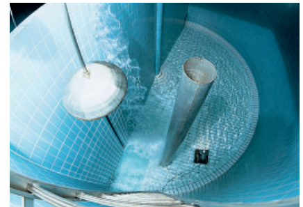
Mit PCI Silcoferm KTW ausgebildete Anschluss- und Bewegungsfugen im Trinkwasserbehälter. Werksfoto: Buchtal
