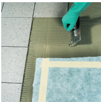
5. Anschließend keramische Beläge ohne Grundierung ...
