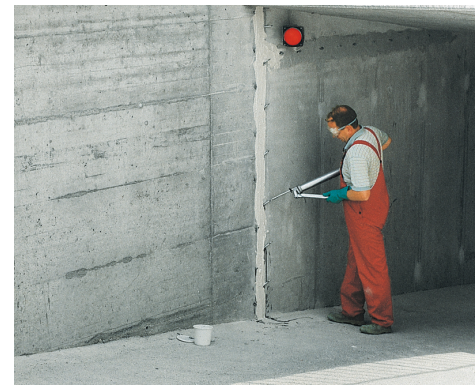
Mit PCI Apogel 1K werden Wassereintrüben in Rissen schnell gestoppt.
