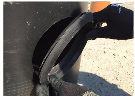
Zulaufdichtung in Bohrung einsetzen.
