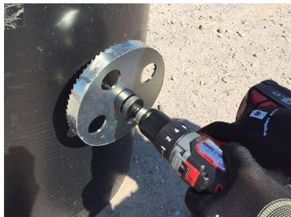
Mittels Lochsäge aufbohren.
