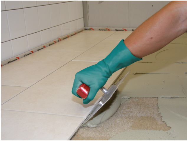
Sopro Flexkleber (z. B. Sopro FKM® XL, Sopro VarioFlex® XL) auf die getrocknete Grundierung aufziehen.
