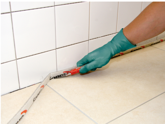
Abschneiden des Sopro RandDämmStreifens mit einem Cutter-Messer.
