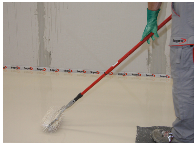
Spachtelmasse mit einer Stachelwalze entlüften. Trocknen lassen und Restfeuchte durch CM-Messung überprüfen. Anschließend einen Sauberkeitsschliff durchführen.
