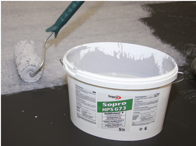
Sopro HaftPrimer S auf den unbesandeten Gussasphaltestrich aufrollen.
