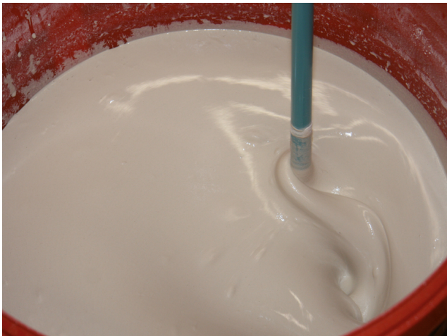
Sopro FS Hybrid in den mit der vorgegebenen Wassermenge gefüllten Anmischeimer schütten und zu einer homogenen und klumpenfreien Masse anmischen.
