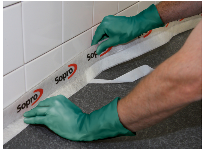
Anbringen des selbstklebenden Sopro RandDämmStreifens nach Trocknung des Sopro HaftPrimer S (1 – 2 Stunden).
