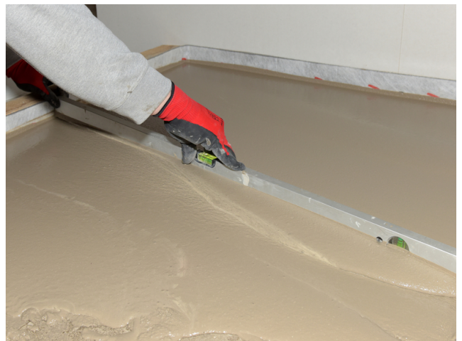
Herstellung eines Gefälles durch Ausbreiten mit der Abziehlatte.
