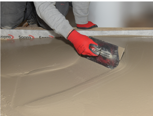
Ausbreiten des VS 582 in Gefällekonsistenz bei maximaler Wasserzugabe.
