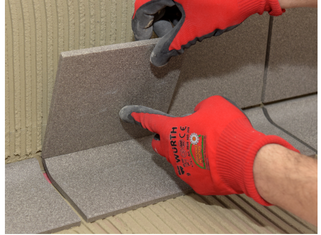
... und Wand verlegt.
