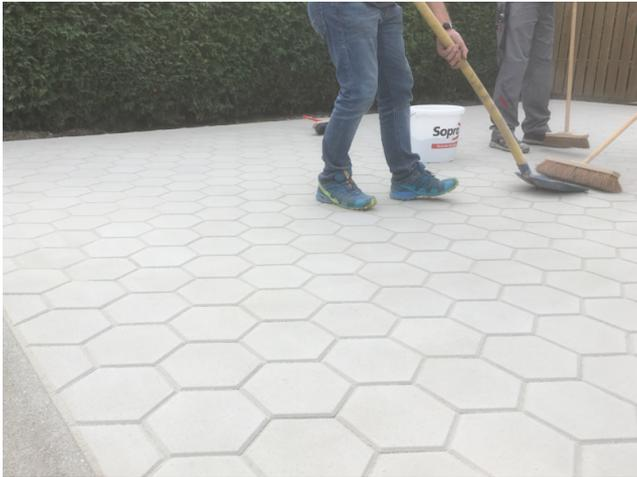
Überschüssigen Fugensand wieder mit einem Kokosbesen diagonal zum Fugenverlauf abkehren, bis sich eine vom Sopro EKS 10 gereinigte Steinoberfläche mit einer ausreichenden Fugenfüllung einstellt.
