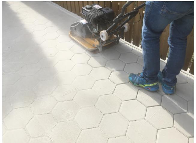
In weiterer Folge ist Sopro EKS 10 unterstützend unter dem Einsatz einer Rüttelplatte mit Kunststoffauflage zu verdichten.
