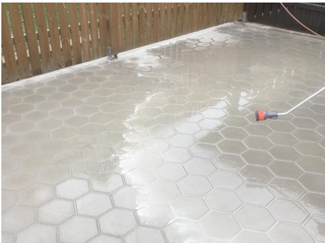
Abschließen ist der Belag diagonal zum Fugenquerschnitt mit einem flach gehaltenen Fächerstrahl sauber abzuwaschen.
