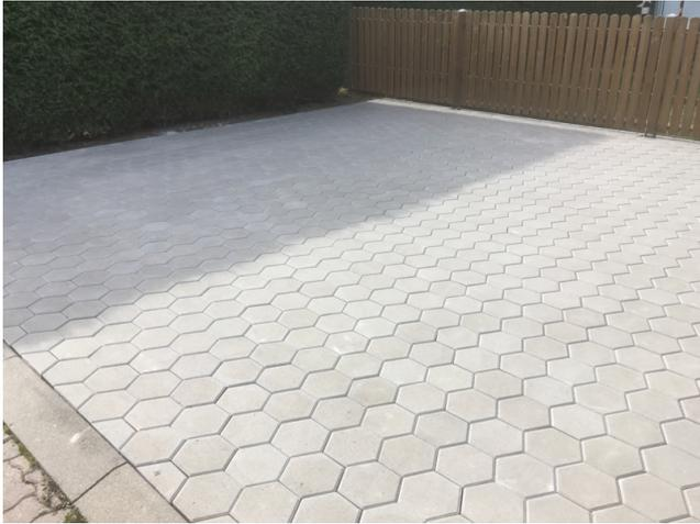
Die zu verfugende Fläche sowie die Steinflanken müssen zum Zeitpunkt des Verfugens trocken sein. Zur Verminderung von Rückständen wird empfohlen die Fläche mit Sopro Pflaster-Fughilfe+ vorzubehandeln.
