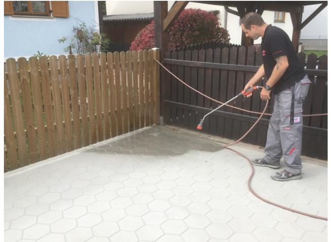
Die Fugenfläche mit einem feinen Wassersprühnebel benässen, wodurch das Bindemittel aktiviert wird und die Stabilisierung der Fuge beginnen kann.
