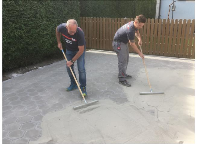
Den gebrauchsfertigen Sopro EKS 10 gleichmäßig auf die zu verfugende Fläche auszuschütten und mit einem Gummischieber verteilen.
