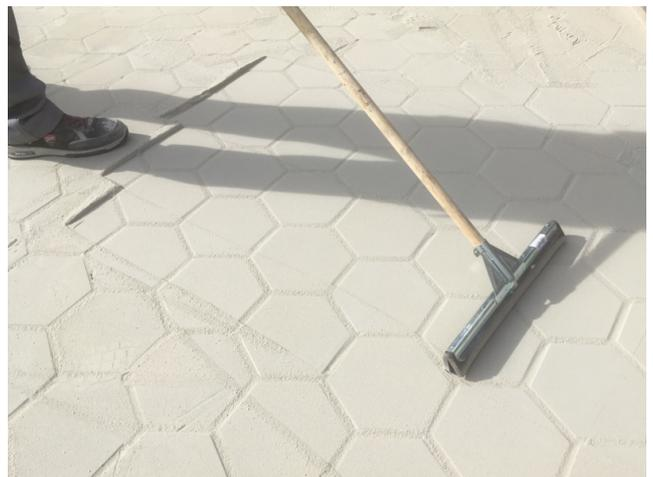
Den Fugensand wieder mit einem Gummischieber gleichmäßig und fugenfüllend verteilen.
