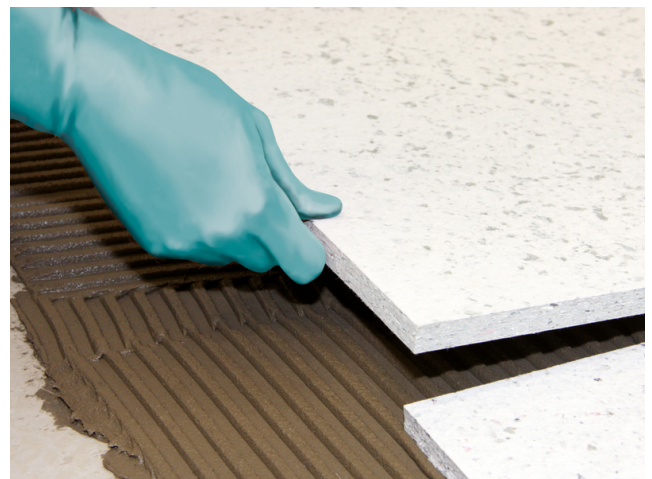
Sopro FliesenDämmPlatten lassen sich leicht verlegen, da sie nur direkt aneinander gestoßen werden müssen.
