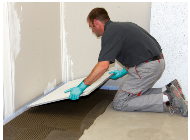
Das Einlegen der Sopro FliesenDämmPlatte erfolgt vollsatt in das frische Mörtelbett.
