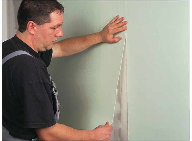
Das zugeschnittene Sopro WE-Vlies wird an den Stößen mittig auf dem Sopro Fixier-Band befestigt.
