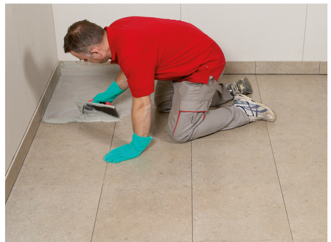
Nach Erreichen der Begeh- und Verfügbareit wird der keramische Fliesenbelag mit z. B. Sopro DF 10® Design-Fuge Flex verfügt.
