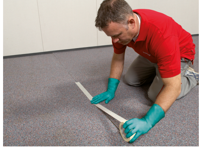
Zur Vermeidung von Mörtelbrücken (Körperschallbrücken) können die Stöße der Bahnen mit Kleband überklebt werden.
