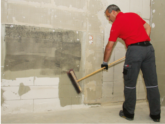
Zu Beginn der Arbeiten den Untergrund von Staub und losen Teilen befreien.
