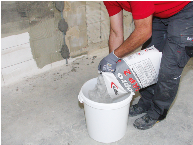
In einen sauberen Anmischeimer Wasser vorgeben, anschließend das Pulver zugeben.
