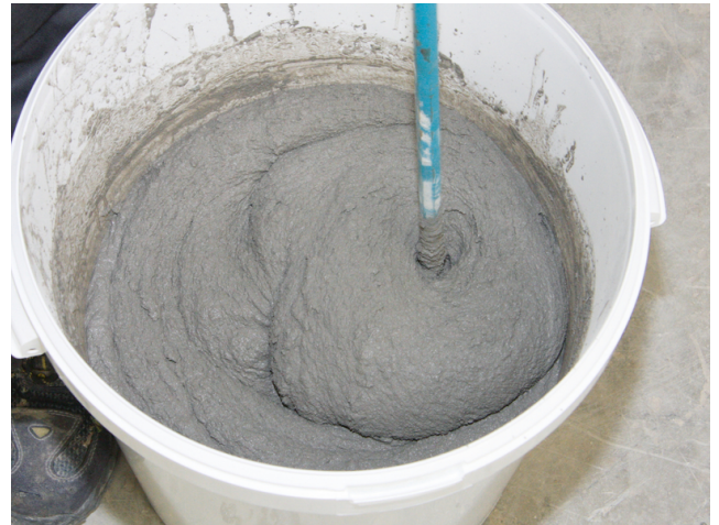
Sopro RAP 2® maschinell knollenfrei anmischen. Nach einer Reifezeit von 3 – 5 Minuten erneut durchmischen.
