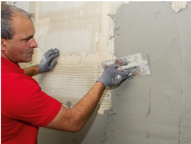
Alternativ kann Sopro RAP 2® mit der Glättkelle aufgebracht werden.
