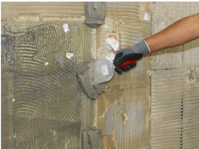
Zum späteren Abziehen des Mörtels werden Putzschienen gesetzt. Hierzu zunächst den Putz in Batzen aufbringen ...
