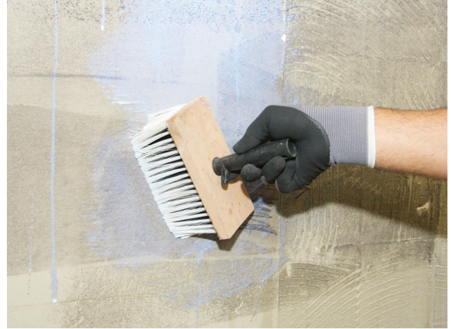
Stark und unterschiedlich saugende Untergründe mit Sopro Grundierung vorbehandeln.
