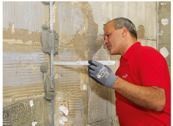
... je nach gewünschter Putzstärke die Schienen mit entsprechendem Abstand zur Wand einbetten, gerade ausrichten und den Mörtel erhärten lassen.
