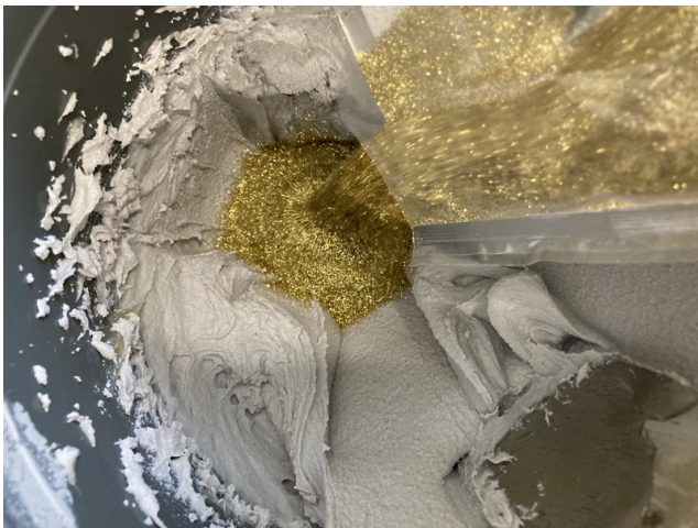
3 Der Sopro Glitter wird in die Öffnung eingefüllt.
