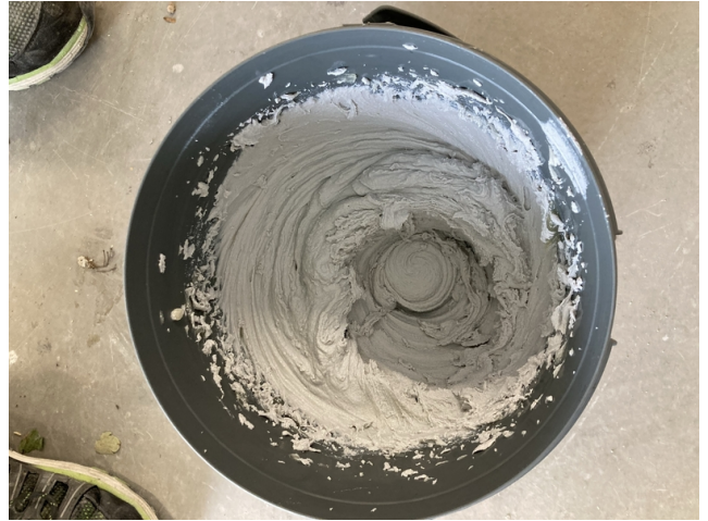
Nach dem ersten Verrühren bleibt eine Öffnung. Nach Bedarf muss diese mit einem Spachtel hergestellt werden.
