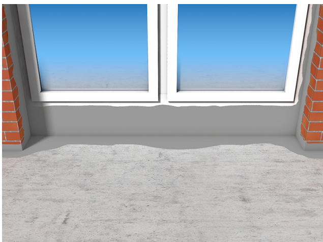
Abdichten an Fensterrahmen
