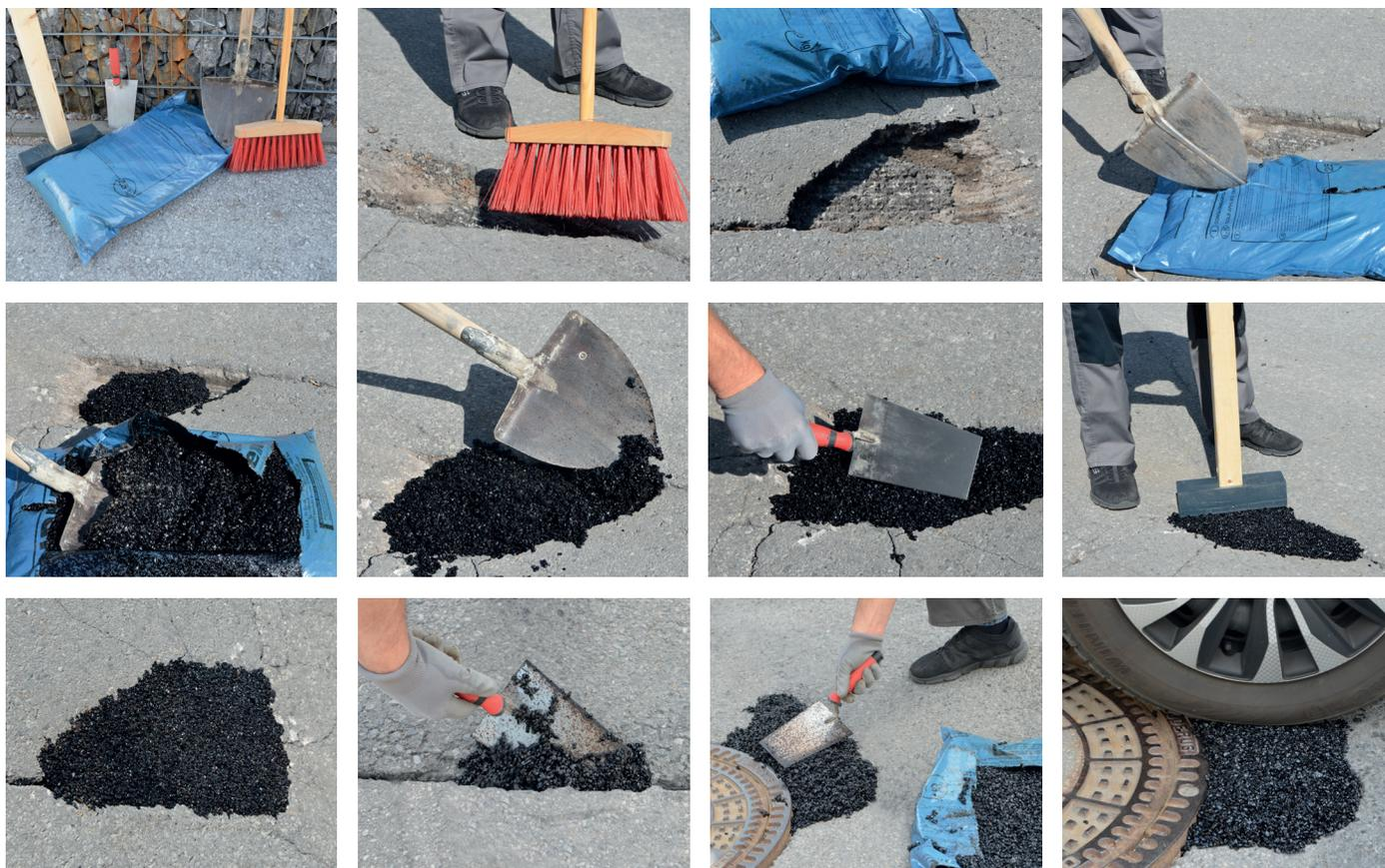
**VERARBEITUNG:** Das Verlegen und Anpressen des Materials erfolgt einfach von Hand mit den üblichen Werkzeugen, Schaufel oder Stampfer, aber Sie können auch Rüttelplatten oder eine schwere Rolle verwenden. Eine mit Inderbit reparierte Fläche kann sofort für den Verkehr genutzt werden, ohne dass darüberfahrende Fahrzeuge ein Anheben oder Abbröckeln verursachen. Die mechanische Beständigkeit des Gemisches nimmt mit der Zeit zu, die Aushärtung wird durch Hitze und Verkehr begünstigt.
