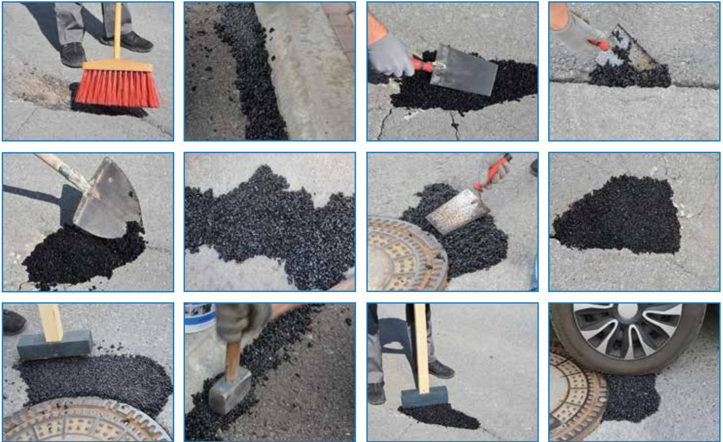
**VERARBEITUNG:** Das Verlegen und Anpressen des Materials erfolgt einfach von Hand mit den üblichen Werkzeugen, Schaufel oder Stampfer, aber Sie können auch Rüttelplatten oder eine schwere Rolle verwenden. Eine mit BITERIP reparierte Fläche kann sofort für den Verkehr genutzt werden, ohne dass darüberfahrende Fahrzeuge ein Anheben oder Abbröckeln verursachen. Die mechanische Beständigkeit des Gemisches nimmt mit der Zeit zu, die Aushärtung wird durch Hitze und Verkehr begünstigt.
