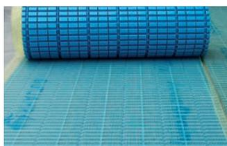
Aqua Drain® EK Rolle wird mit den Drainkanälen in Gefällerrichtung auf dem Untergrund ausgerollt.
