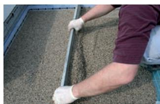
Drainmörtel wird auf die Aqua Drain® EK Flächendrainage aufgetragen und für die Verlegung des Belages vorgezogen.
