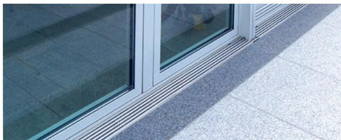
Drainroste führen zusätzliche Wassermengen in die Drainschicht, die schnell und rückstaufrei abgeleitet werden müssen.
