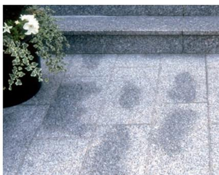
Staufeuchte in wasserspeichernden Mörtelschichten führt zwangsläufig zu Feuchteschäden bzw -flecken.
