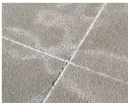
Außenbeläge sind nicht wasserdicht und eingedrungene Feuchtigkeit will wieder entweichen – die entstehenden Ausblühungen erfordern in der Regel eine Komplettsanierung.
