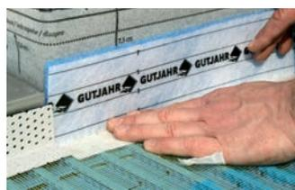
An aufgehenden Bauteilen ist eine Bewegungsfuge von 8-10 mm einzuhalten, einfach durch Aufkleben des Aqua Drain® RD Randdämmstreifens.
