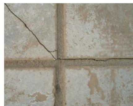
Risse im Belag sind meist die Folge von Scherspannungen in der Unterkonstruktion. Die Sanierung ist nicht nur aufwändig, sondern auch ärgerlich, denn sie wäre vermeidbar gewesen.
