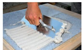
Der Naturwerkstein wird rückseitig abgespachtelt und anschließend frisch in frisch im Mörtelbett verlegt.
