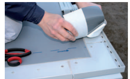
Sicher: Mit selbstklebenden Systemdichtbändern.
