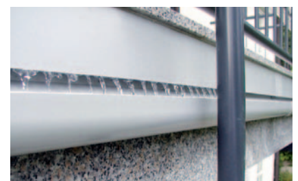
Intelligent: Verdeckte Entwässerungsschlitze.
