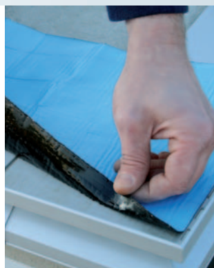
Das DiProtec® KSK-AB Abdichtungsband – ausgestattet mit einem zweigeteilten Silikonpapier – wird auf den Profilschenkel aufgeklebt.
