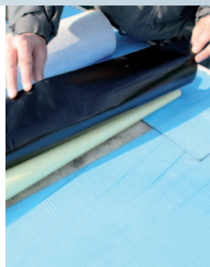
Zum Verkleben mit dem Untergrund wird die DiProtec® KSK-Bahn umgeschlagen, das Silikonpapier abgezogen und die Bahnen mit mind. 10 cm Überlappung verklebt.
