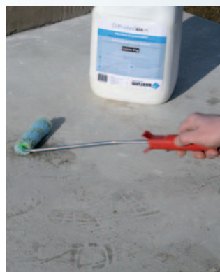
Abzudichtende Flächen, Boden und Sockelbereich werden mit DiProtec® PR-ZE Primer grundiert.
