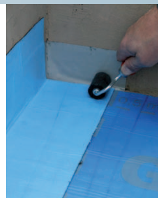
Der Boden-Wandanschluss erfolgt mit dem DiProtec® KSK-AB Abdichtungsband, das ebenfalls mit 10 cm Überlappung mit der DiProtec® KSK-Bahn verklebt wird.
