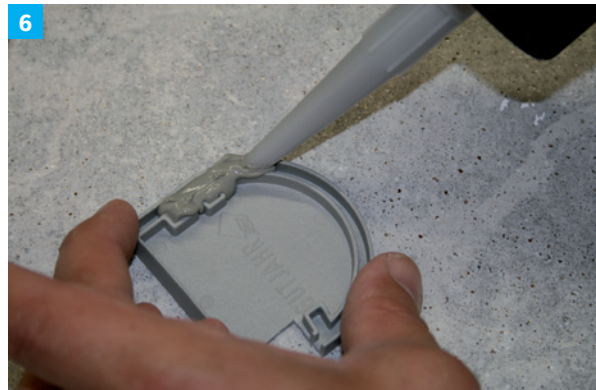
Die Rinnenenden werden mit den ProRin® BR Endkappen verschlossen. (DiProtec®FIX-MSP)
