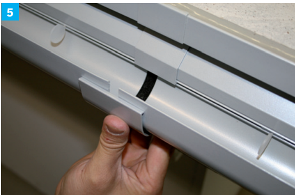
Die einzelnen Elemente mit den ProRin® BR Rinnenverbindern zusammenfügen.
