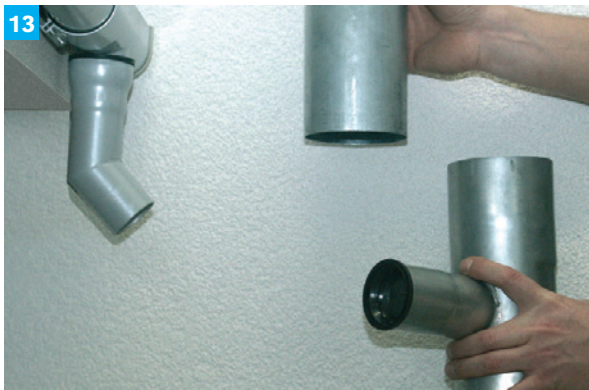
13 Anschluss der Entwässerung an ein bestehendes Fallrohr mit dem ProRin® AL Fallrohradapter DN 100...
