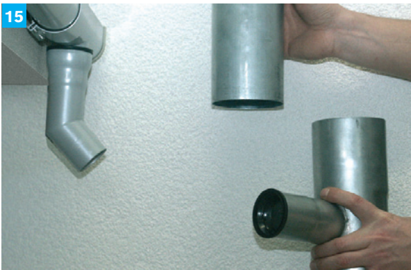
Anschluss der Entwässerung an ein bestehendes Fallrohr mit dem ProRin® AL Fallrohradapter DN 100...
