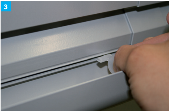
...und mit den Arretierclipsen sichern.
