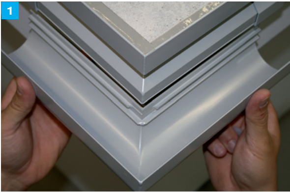
An den Balkon- bzw. Terrassenecken beginnen:
