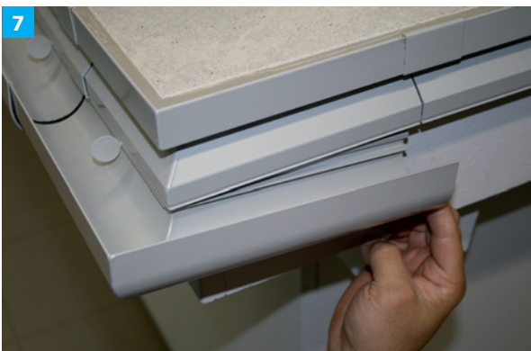
Die Rinnenaußenecke vorderseitig eingehängen und arretieren. Auf der Seite, auf der die ProRin® GB Gefälleblende eingebaut werden soll, wird die Rinne nicht eingehängt.
