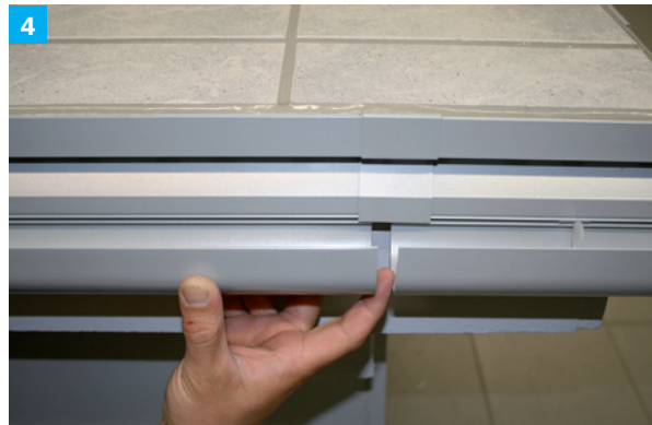
Im Stoßbereich benachbarter Balkonrinnen 5 – 8 mm „Bewegungsfuge“ einhalten.
