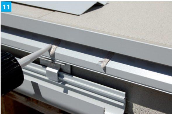
11 DiProtec®FIX-MSP Streifen im Abstand von 10 – 15 mm auftragen, ...
