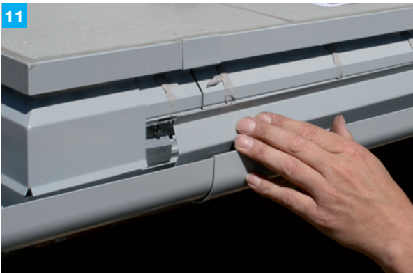
wie unter Bild Nr. 12 werden die ProRin® RB Rinnenblenden in die frischen DiProtec® FIX-MSP Streifen eingesetzt.
