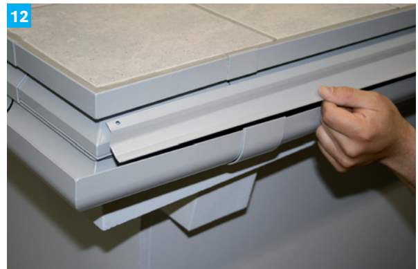
12 ... ProRin®GB Gefälleblende an das Drainabschlußprofil ansetzen und in die frischen Fixierstreifen eindrücken.
