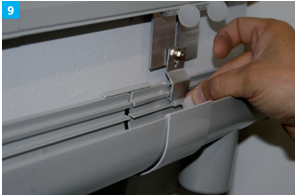
9 ... und dann Rinnenhalter und ProRin® BR Balkonrinne einhängen. Mit Arretierclipsen sichern.
