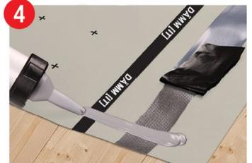
4 Alle Querstöße werden mit FOLIEN KLEB- UND DICHTSTOFF PRO miteinander verklebt.
