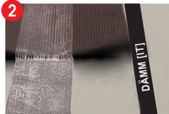
2 Dadurch entsteht eine doppelte Verklebung. Klebstoff auf Klebstoff.
