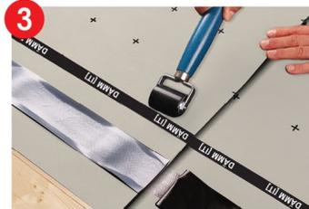
3 Die Nähte werden mittels Hartgummiwalze einmalig nachgewalzt.
