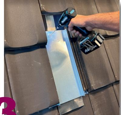
**3** Blechziegel mittels Dichtschraube auf den Dachlatten befestigen
