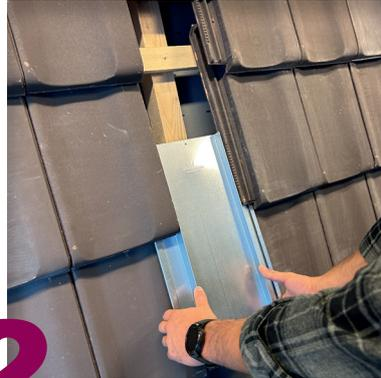
**2** Blechziegel von Dämm[it] einsetzen
