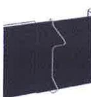
5. An jeder Verbindungsstelle ist eine Stoßsicherung zu montieren. Stoßklammer unten zuerst einhängen. Folienstreifen zum Schutz wieder über die Verbindung zurückrollen und andrücken
