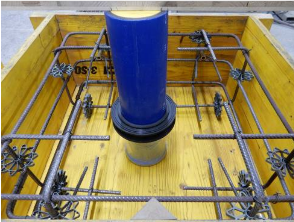
Bild 3 Einbausituation mit Filterpapier und Folie an der (hier) Unterseite
