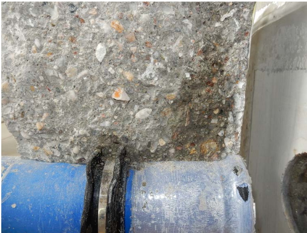
Bild 6 dto., andere Prüfkörperhälfte mit eingebundenem Rohr und Doppelmuerkragen
